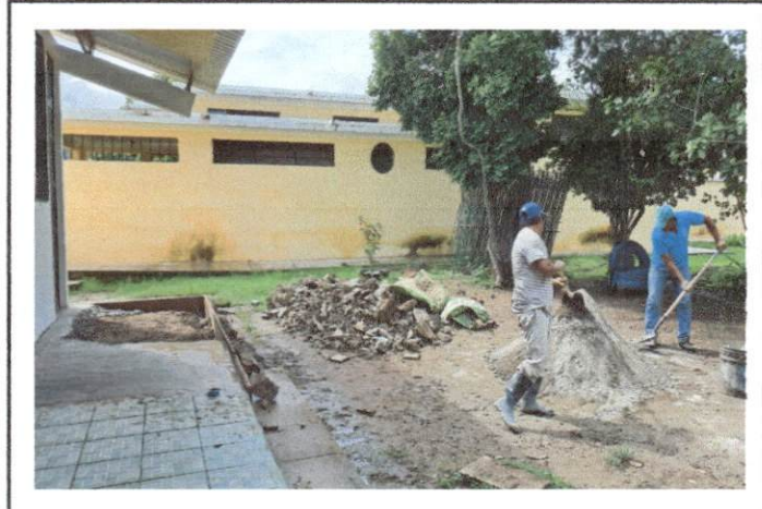
Foto1: Colocación de piso ceramico antideslizante en corredor anexo 2.
