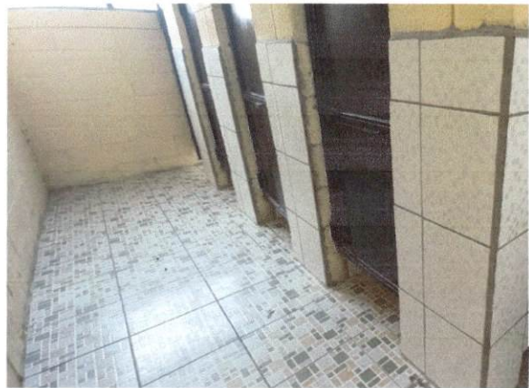
Reparación de servicios sanitarios.
