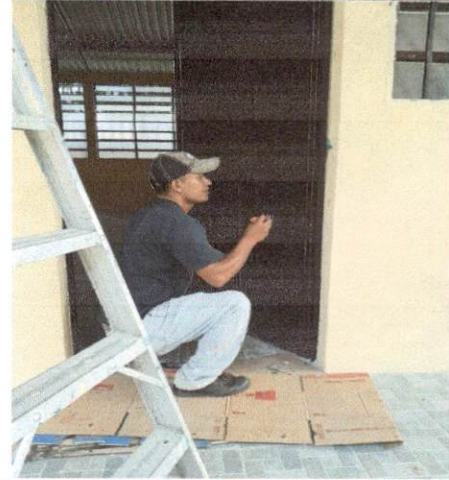
Cambio de la puerta en aula ubicada al este de la escuela.
